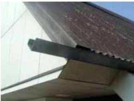
*Lastre ondulate in cemento amianto*
