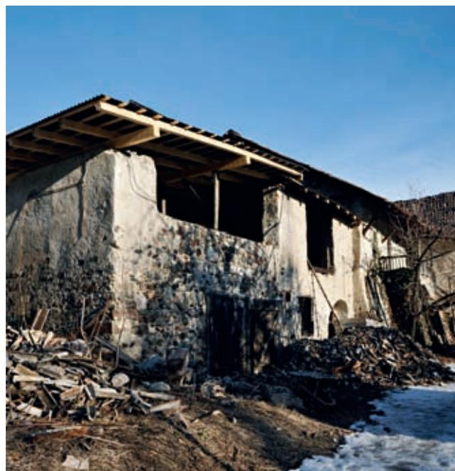
durch letzte Umbauarbeiten stark beeinträchtigt worden. Von einem aufwendigen Innenausbau mit Wärmedämmung und Einbau einer Lüftung konnten die Zisterzienserinnen nicht abgebracht werden. Somit sind im Inneren die historischen Oberflächen nicht mehr einsichtig. Die Fassaden wurden laut Befund getüncht und die Fenster analog dem Nachbargebäude erneuert. ht
