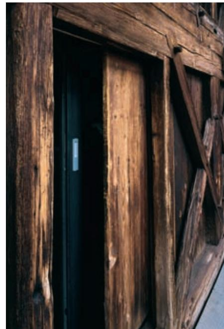
Stube und die Stubenkammer wurden abgebaut, gereinigt und teilweise ergänzt und nach der statischen Sicherung des darunterliegenden Mauerwerks wieder eingebaut. Das Dach wurde mit Schindeln neu eingedeckt. Die vom Amt großzügig unterstützte Sanierung und Restaurierung des Hauses Schussbrugg zählt – was die Ausführungsqualität und das Ergebnis angeht, das trotz widriger Ausgangsbedingungen erzielt wurde – sicher zu den größten Erfolgen der Denkmalschutzfähigkeit im Berichtsjahr. pfb
