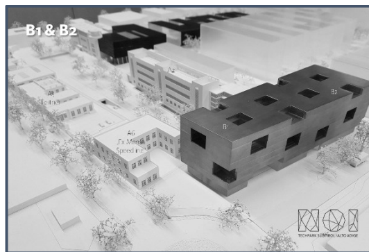
Lavori edili in corso e plastico. (Fonte: BLS Alto Adige)
