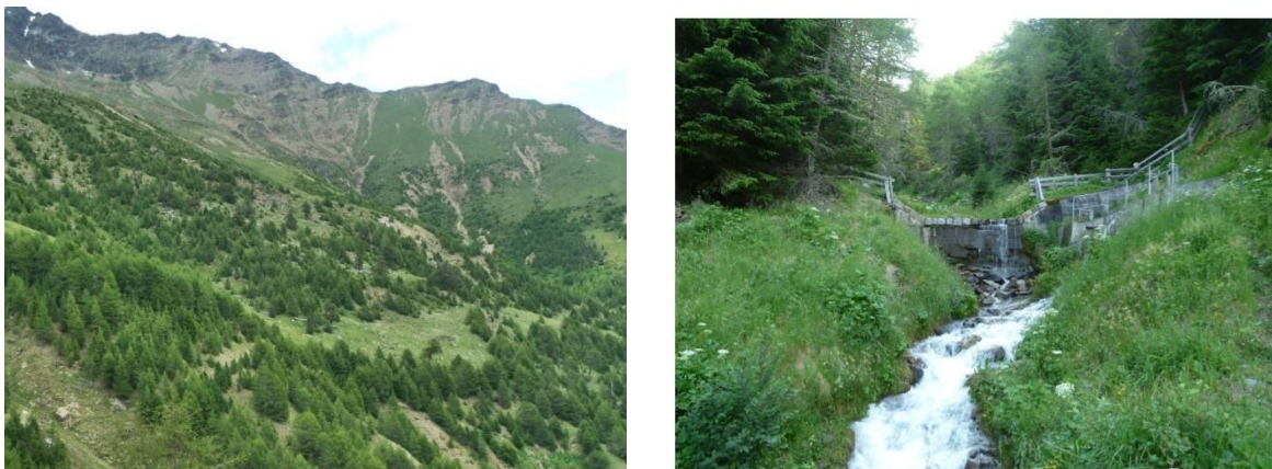
Abbildung 3-2: Blick ins Quellgebiet des Tanaser Bachs (links). Geschieberückhaltesperre im Mittellauf des Tanaser Bachs (rechts).
