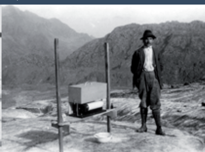
Installation eines Ablationsmessgeräts Installato l'ablatografo
