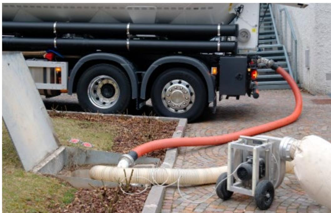
*Fase di riempimento di un serbatoio interato mediante autobotte certificata: in primo piano il ventilatore di estrazione dell'aria.*
