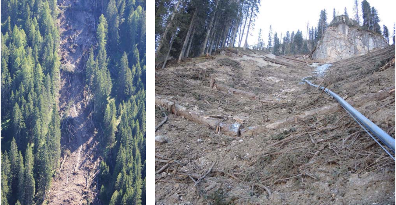
Abbildung 15: links: zentraler Bereich der Hangmure. Deutlich erkennbar ist die breiige Konsistenz des Materials; rechts: Stabilisierung der Hangmure mit ingenieurbioologischen Maßnahmen (Aufnahme Dezember 2016)
