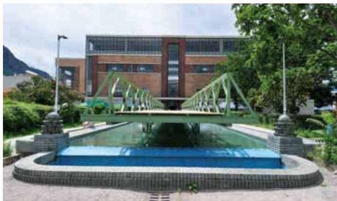
Installazione all'Ex-Alumix Bolzano
