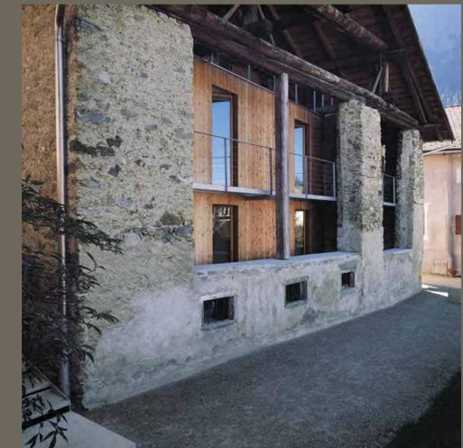
Beim Umbau des ehemaligen Kornkastens zum Wohnhaus wurde der alte Stadel abgetragen und durch einen vierachsigen Zubau ersetzt. Alt- und Neubau bleiben unter einem Dach vereinigt.
