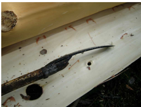
Abb. 2: „Schleissen“ des Rundholzes mit dem „Schleisseisen“
