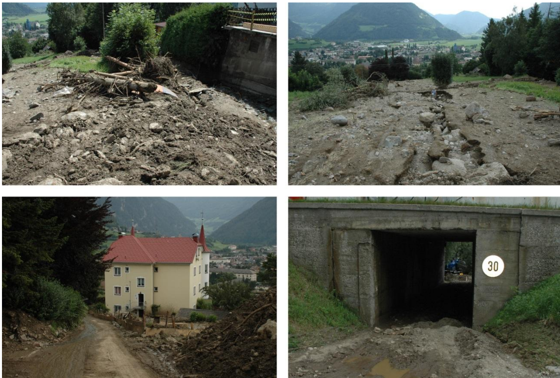
Abbildung 5: Bilder der Situation nach dem Schadensereignis, das durch den Murgang am Riesenbach vom 04.08.2012 verursacht wurde.
