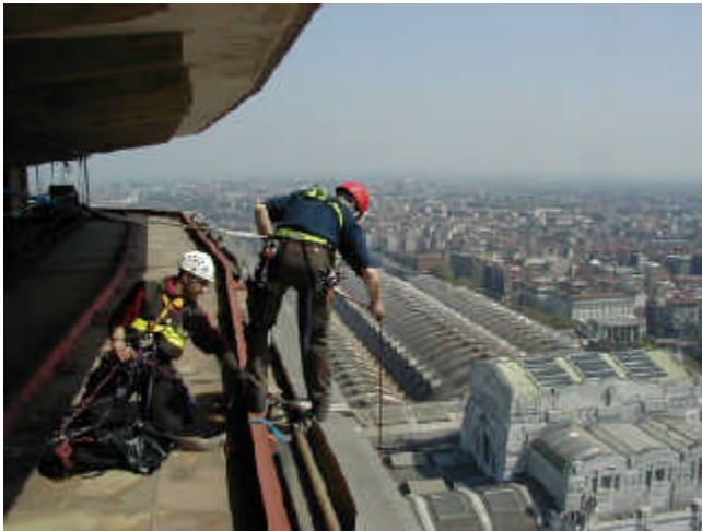
Realizzazione degli ancoraggi statici sul tetto dell'edificio
