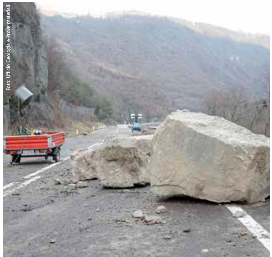
La frana che ha invaso la strada statale del Brennero a Campodazzo, nel frattempo riaperta al traffico.
